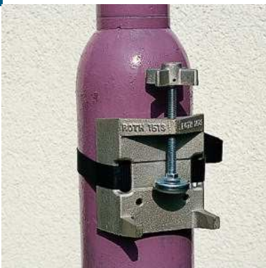
Druckgasflaschen sind gegen Umfallen zu sichern
